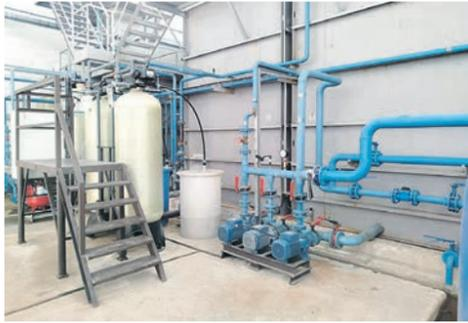
В Устьянском лесопромышленном комплексе завершились ремонтные работы на главной насосной станции. Специалисты завода выполнили ревизию циркуляционных и подпиточных насосов, заменили клапаны, запорную и регулирующую арматуру, провели чистку накопителей для чистой воды, а также обслужили щиты управления комплексом водоподготовки. Насосная станция обеспечивает подачу технической и питьевой воды во все производственные цеха, а также общежитие и кафе.
