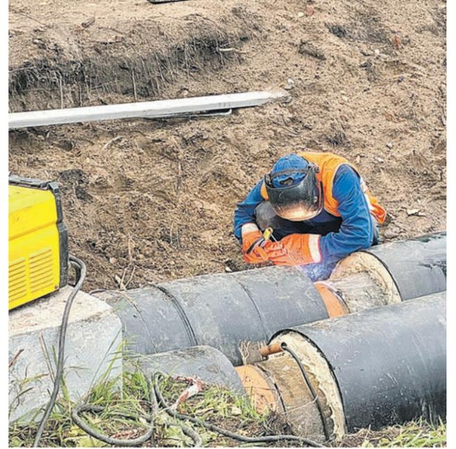
Специалисты Устьянской теплоэнергетической компании в кратчайшие сроки устранили аварию на магистральном трубопроводе холодного водоснабжения по ул. Зеленой в п. Октябрьский. В ходе работ был заменен дефектный участок трубопровода протяженностью 35 метров, обеспечивающий водоснабжение трех многоквартирных жилых домов.
